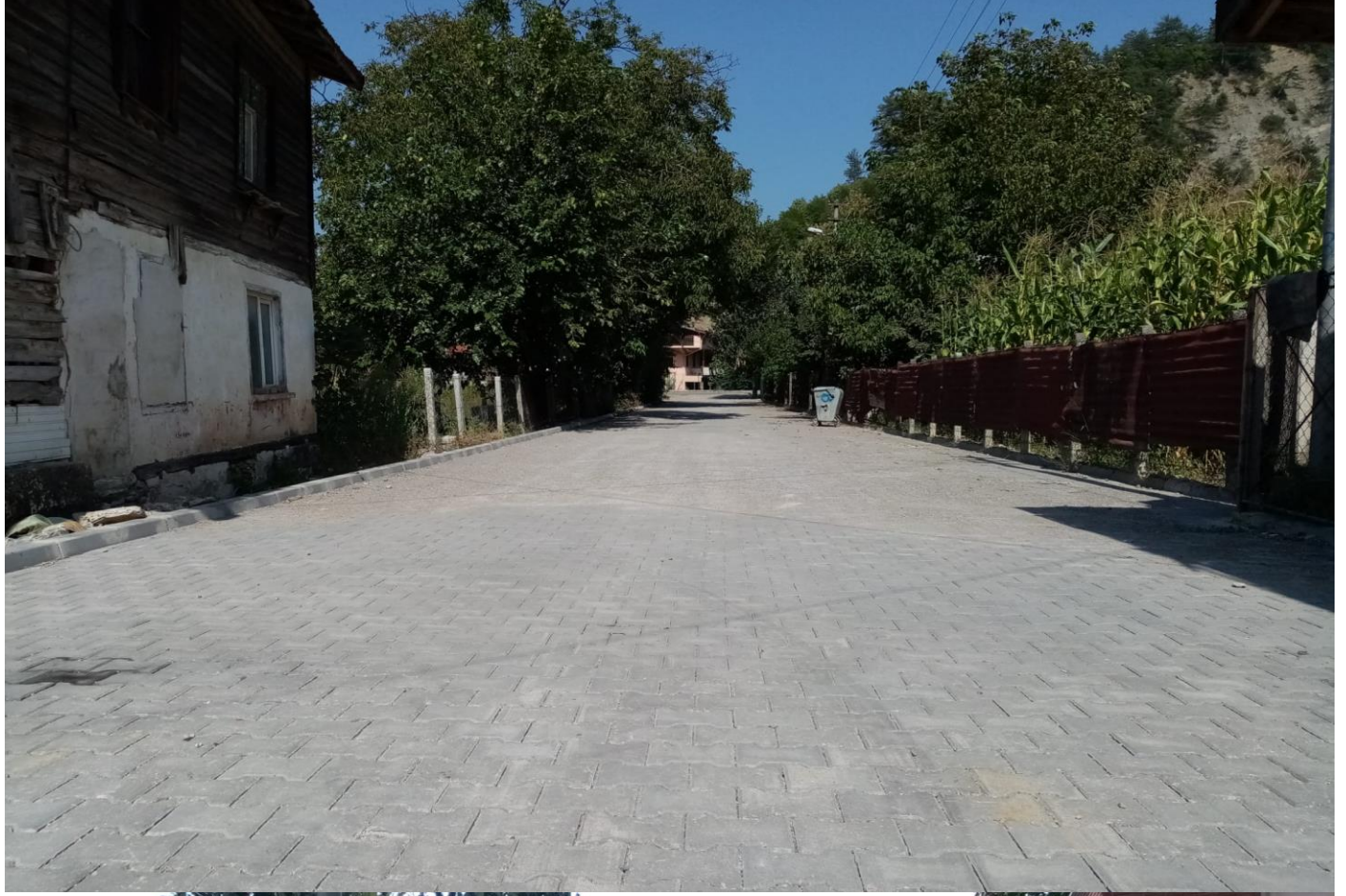
17- SAMAT MAHALLESİ ELDEŞ1 DEĞİRMEN SOKAK YOL DÜZENLEME İŞİ 200 mt Bordür-700 m2 Beton Kilit Parke Döşenmiştir.
